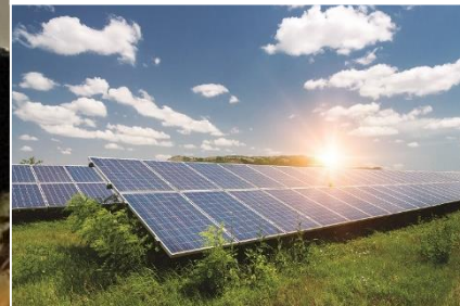
▶ ソーラー施設監視
